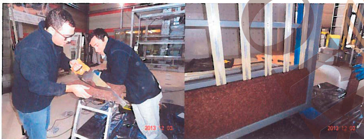
Figura 6: Abas dos perfis montantes com primário aplicado.
