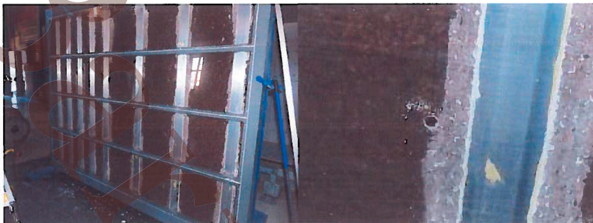
Figura 10: Aplicação e furação de chapas de acrílico no tardo do provete.
