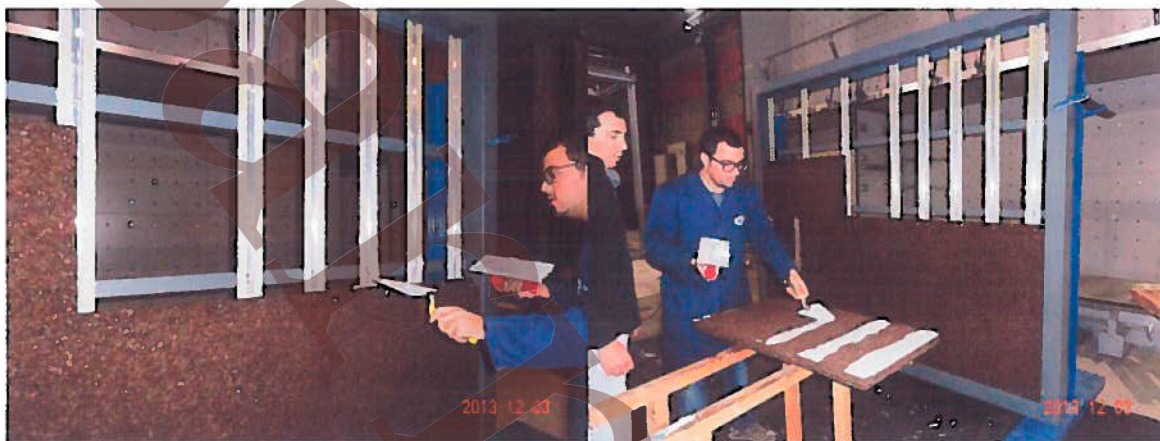
Figura 8: Aplicação da argamassa de colagem nas abas dos montantes e nas placas.
