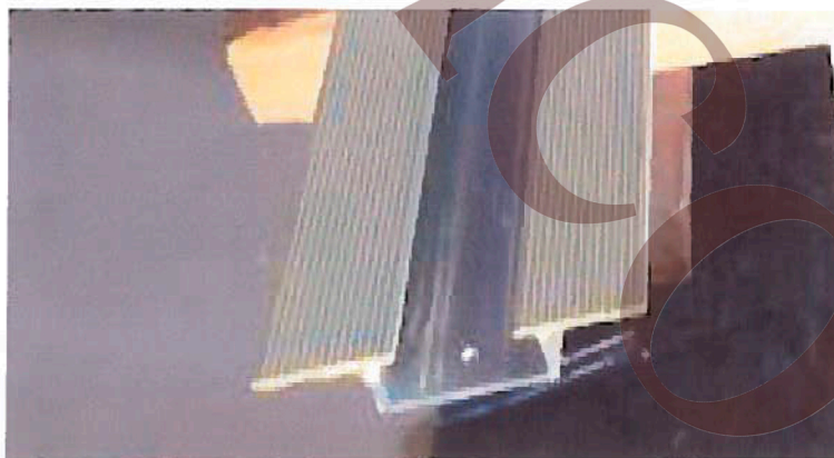
Figura 2: Secção dos perfis montantes.
